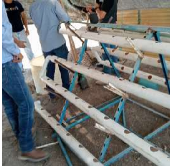
Figura 2. Instalación del tanque de agua inmerso en la tierra.
